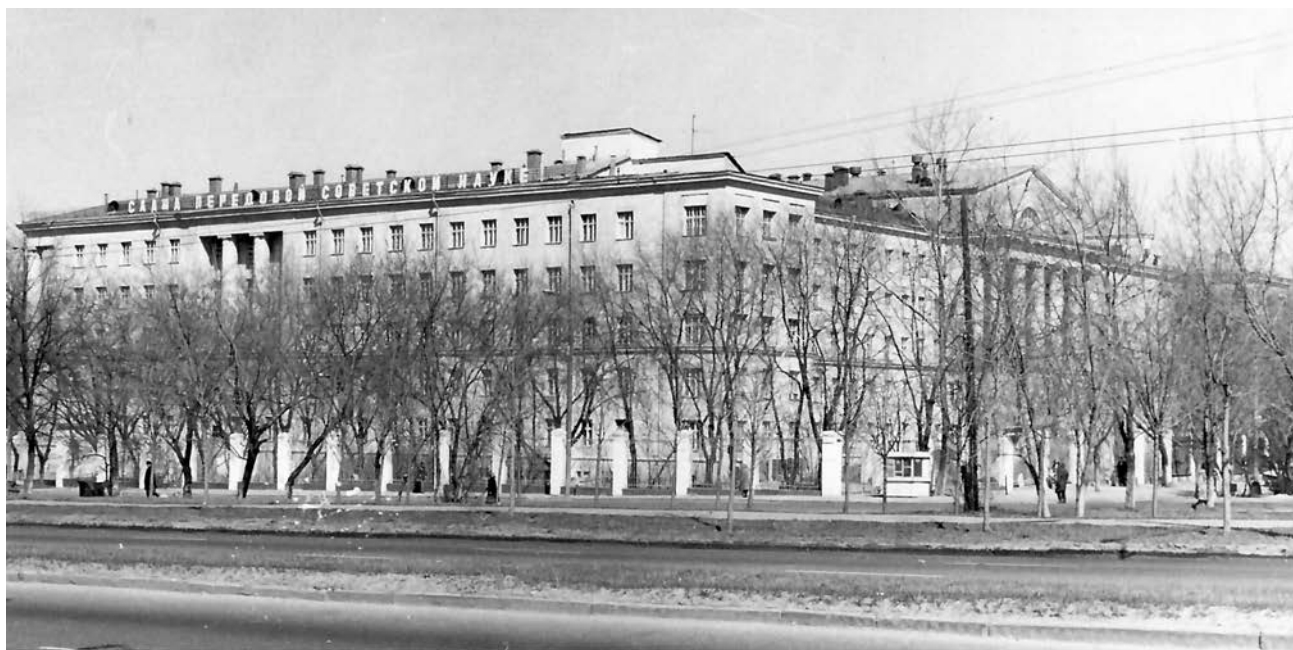
Рис. 6. Здание Центра на Волоколамском шоссе (вид в 1965 г.).
